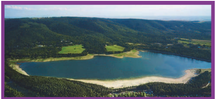
Bassin de Saint-Ferréol (6)
